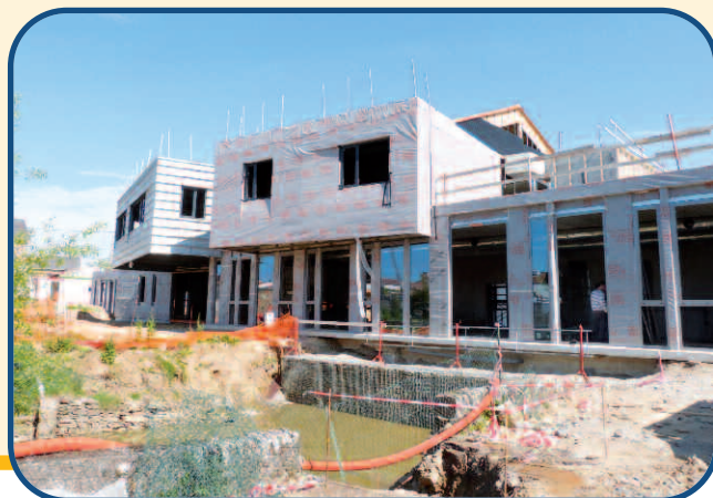
Médiathèque et pôle associatif en construction
