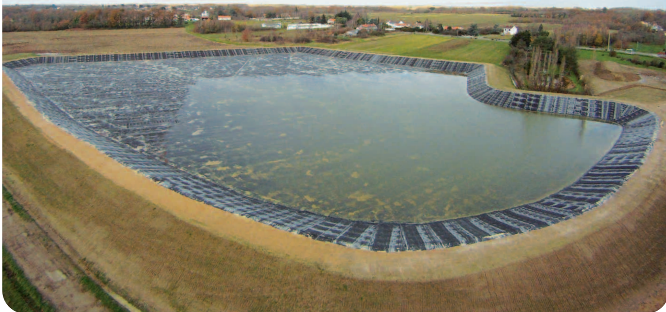
Le bassin de stockage des eaux assainies de la nouvelle STEP
