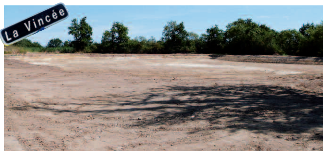
Réalisation du futur bassin de rétention
