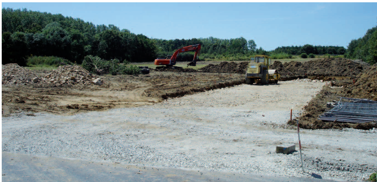
Démarrage de chantier pour la troisième tranche du lotissement du Haugard
