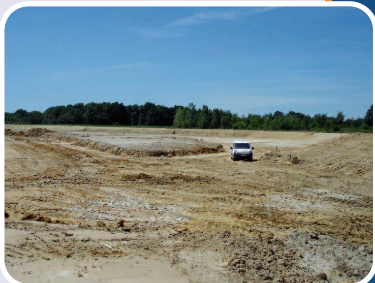
Création d'un bassin de stockage des eaux assainies
