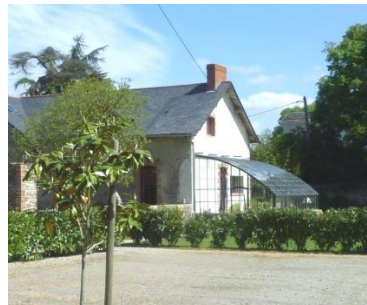
Exemple d'évolution du bâti ne dénaturant pas l'harmonie du bâti ancien (dépendance du château)
