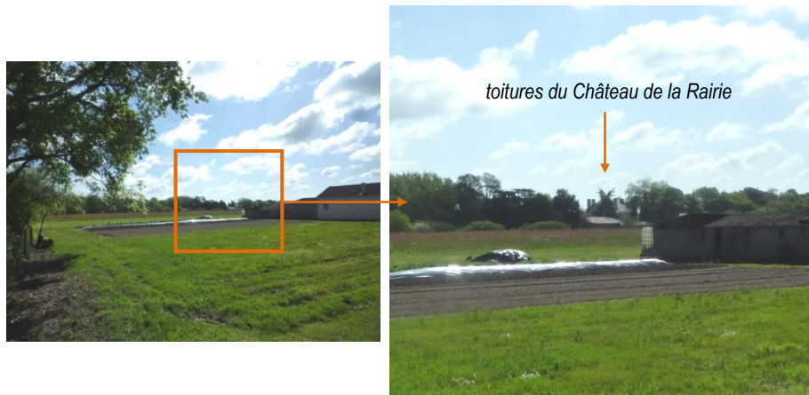
(A) Une des deux vues repérées sur le château, depuis la RD65
