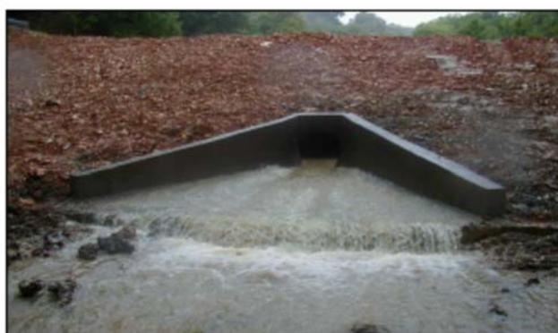
**Figure 13 : Ouvrage de diffusion du débit de fuite d'un bassin**
