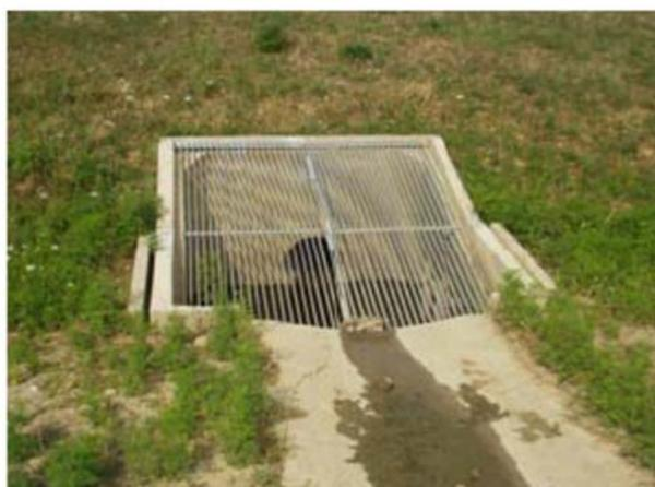
**Figure 12 : Grille de protection sur ouvrage de sortie**
