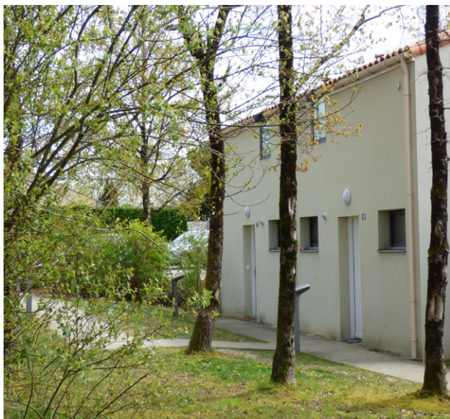
Le clos des Hirondelles, Pont Saint Martin, avril 2021.
