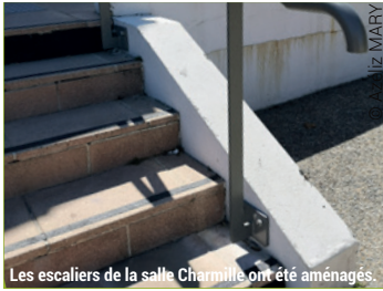
Les escaliers de la salle Charmitte ont été aménagés.
