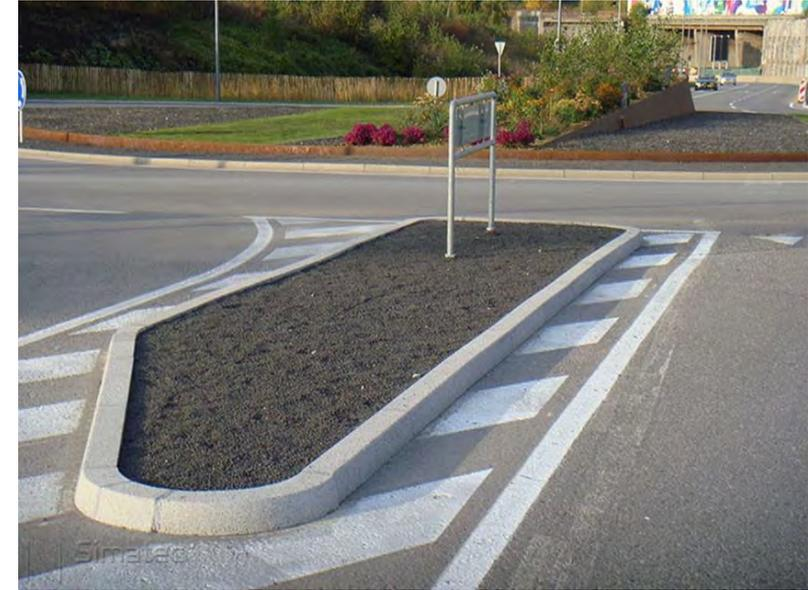
Mise en place de bordures collées pour réalisation d'îlots et d'écluses
