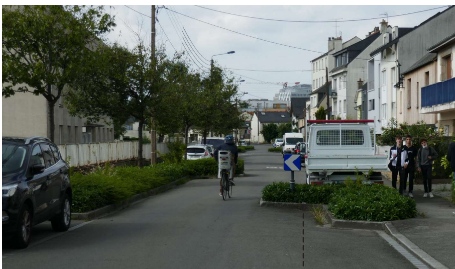
Rétrécissement de chaussée d'un seul côté de la voie
