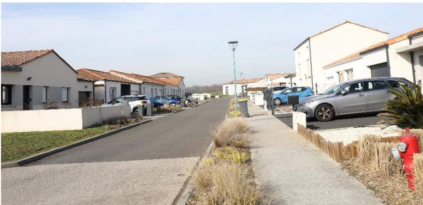
Une bande plantée résiduelle pour séparer les piétons de la voirie
