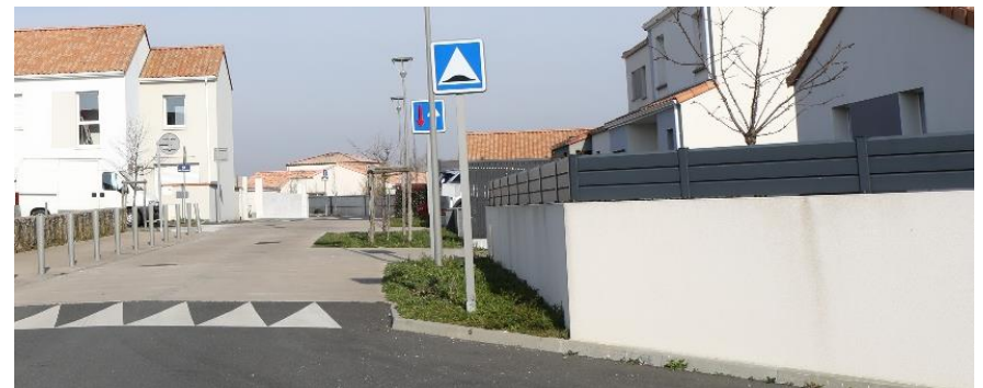
Des chicanes avec arbres qui permettent de faire ralentir les voitures sur des voiries partagées
